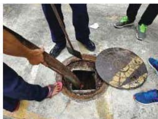
การสูบน้ำจากระบบบำบัดน้ำเสีย
